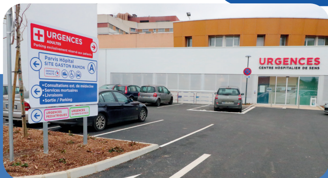
La nouvelle entrée des urgences
