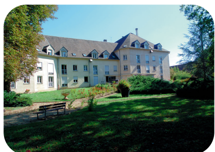
Résidence les Rives d'Yonne (EHPAD) 1, rue de Port 89500 V/Yonne 03 86 87 38 02
